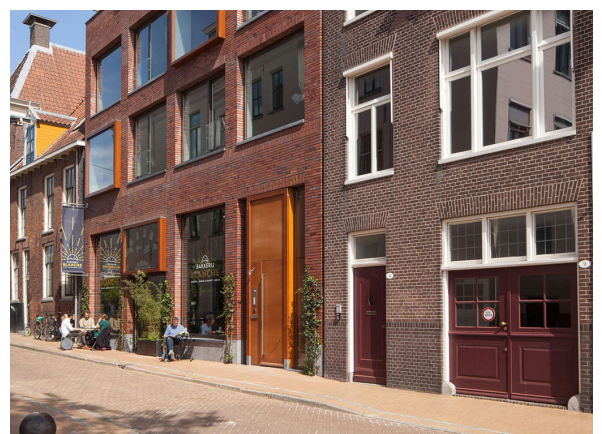
Publieke voorzieningen en woningentrees aan de Dorpsstraat
